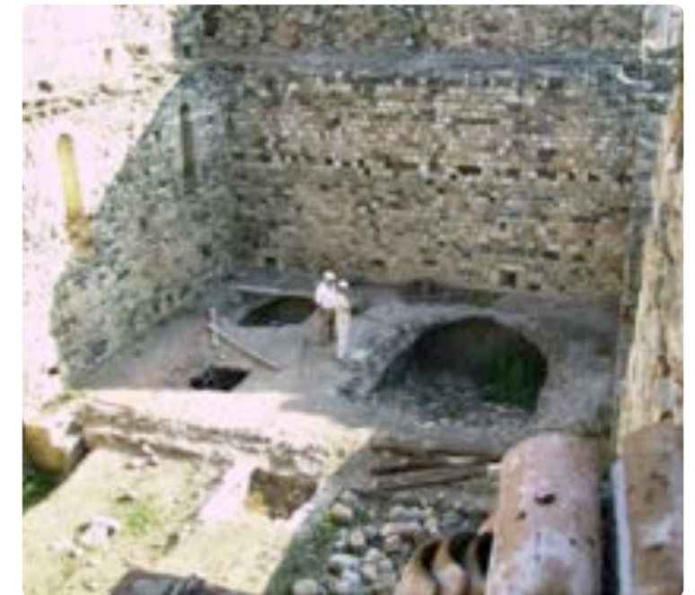
Figura 4. Estat inicial. Presència de les sitges-fonaments de pedra referència de l'arc diafragma complet i aïllat de la nau menor.
