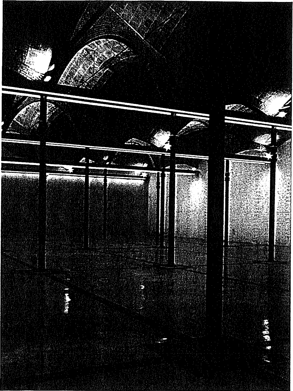
MUSEU DE LA CIÈNCIA I DE LA TÈCNICA DE CATALUNYA, a Terrassa. Adequació de l'antiga fàbrica construint-hi un nou soterrani dessota l'edificació. (1996).
