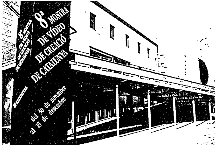
Convento de Santa Mònica. Fachada a la Rambla con el nuevo acceso.
