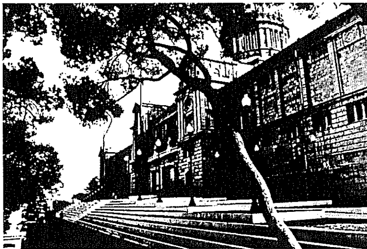
Palau Nacional de Montjuïc. Fachada principal con el nuevo acceso.
