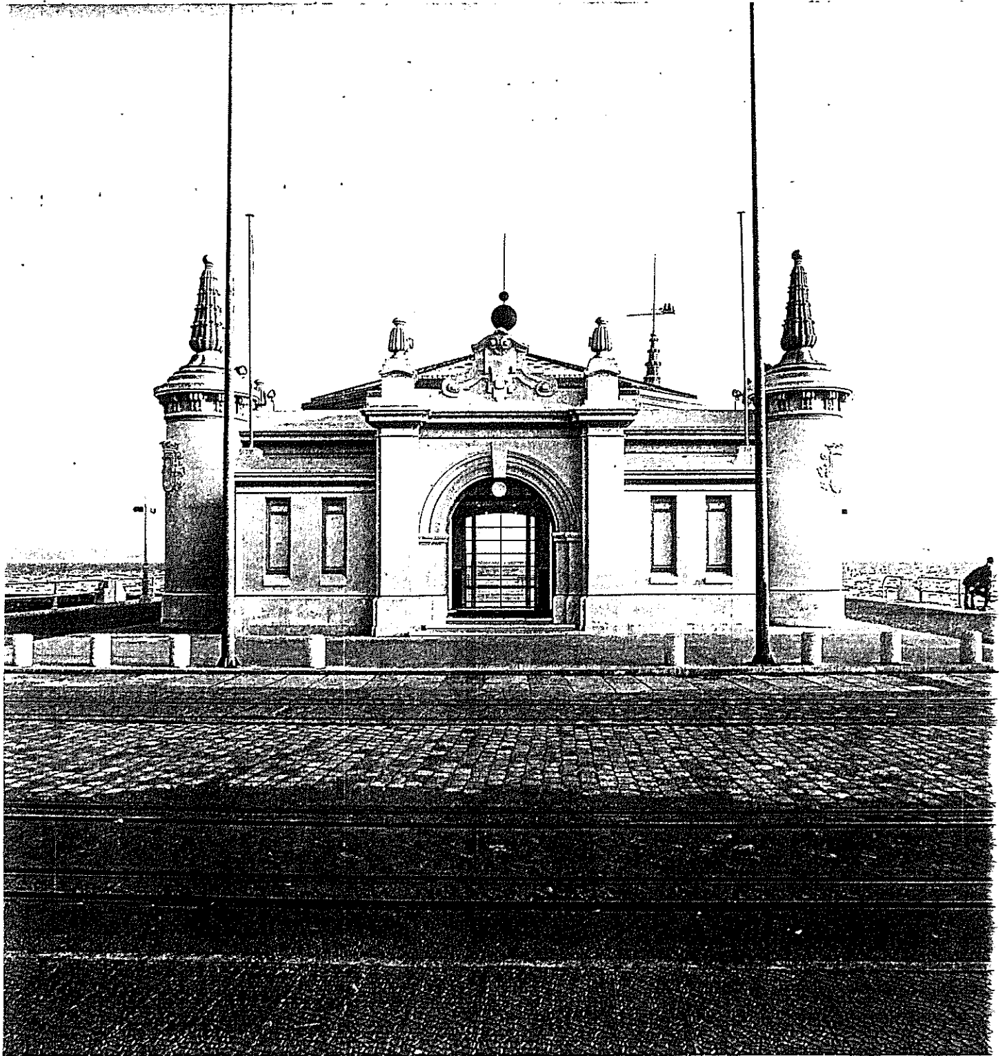
Palacete-Embarcadero: Alzado norte rehabilitado
