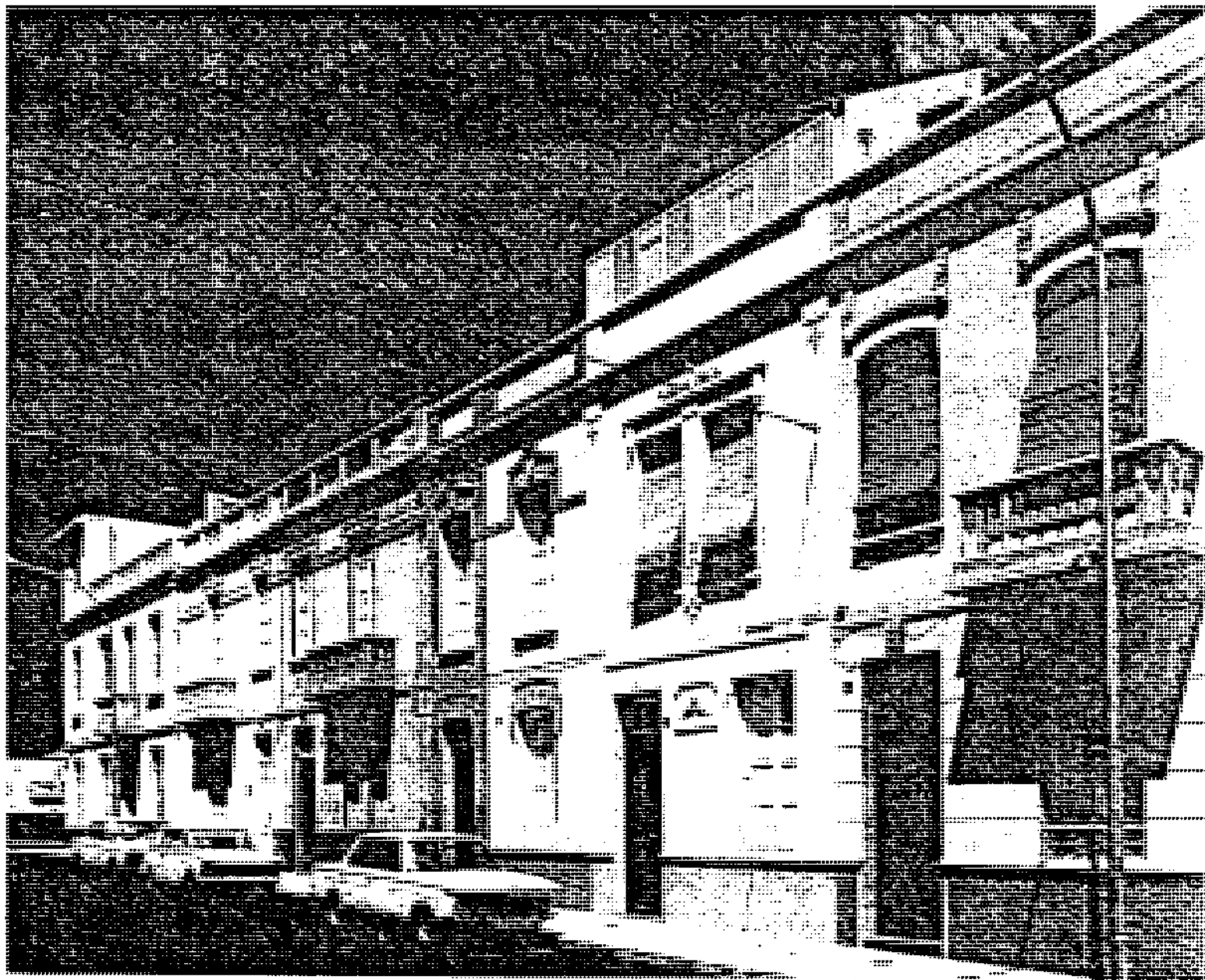
Edificaciones residenciales unifamiliares. Calle Julio Tovar. Barrio de Salamanca.
