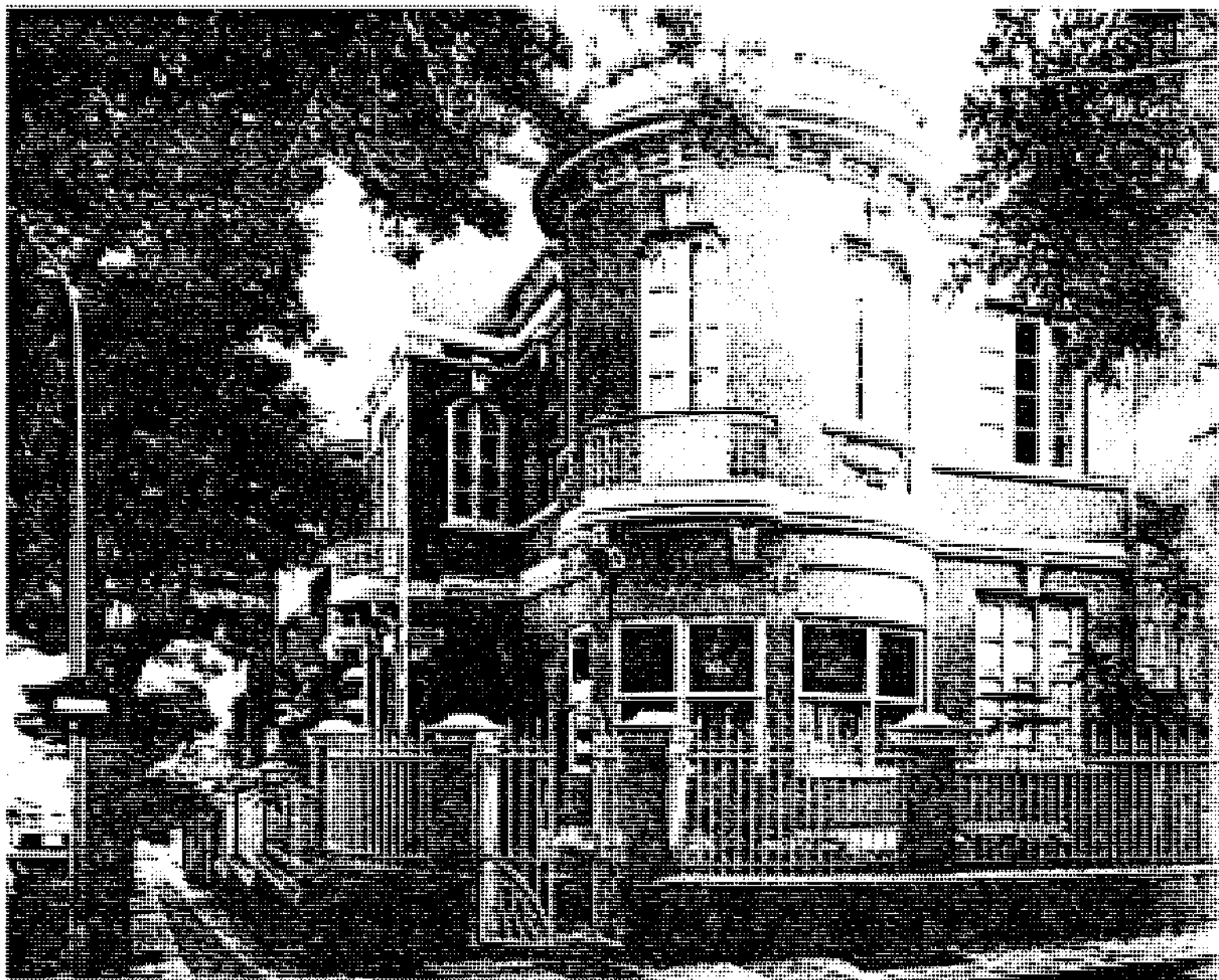
Edificación residencial unifamiliar con jardín delantero. Calle Robayna esquina Rambla General Franco
