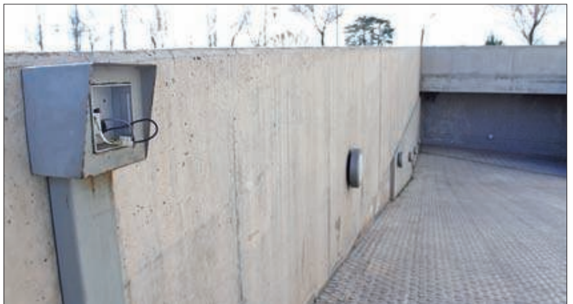
FOTO: T. Alcántara / Imagen del bombín de acceso al parking que se encuentra roto desde el mes de octubre
