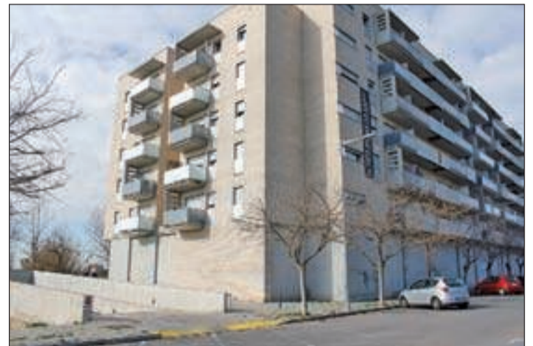
FOTO: T. A. / El edificio se encuentra en la calle Cal Bernet de Copa d'Or
