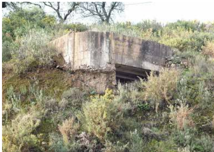
AL TERRENY. Les construccions es van edificar adaptant-se al terreny
