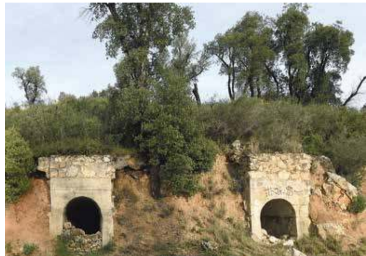
BÚNQUERS. Algunes estructures estan situades al costat de l'N-II
