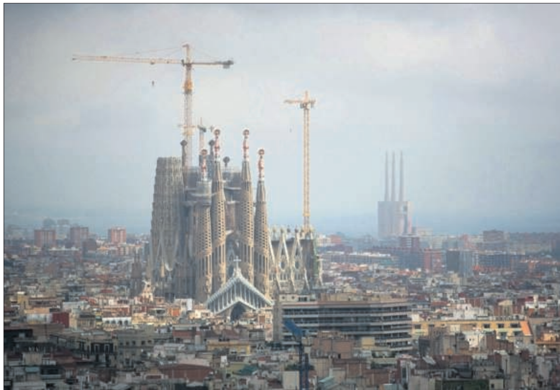
Las obras de la Sagrada Família, con las tres chimeneas del Besòs de fondo. / ALBERT GARCIA
