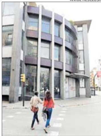
L'edifici, a la carretera Barcelona.
