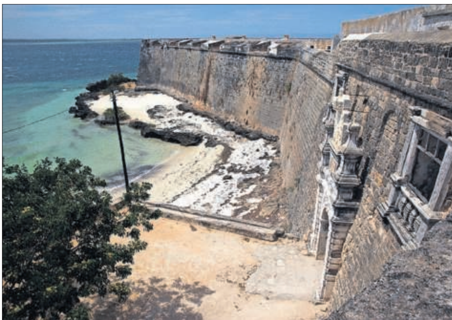
Arriba, Casa de los esclavos, en la isla de Gorea (Senegal), de donde partían buques negreros. Sobre estas líneas, fortaleza de San Sebastián (Mozambique). / CÉSAR FRAGA
