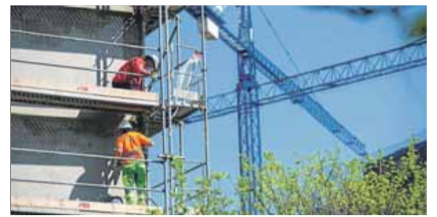
Treballadors de la construcció en unes obres de fa uns dies a Domeny ■ QUIM PUIG
