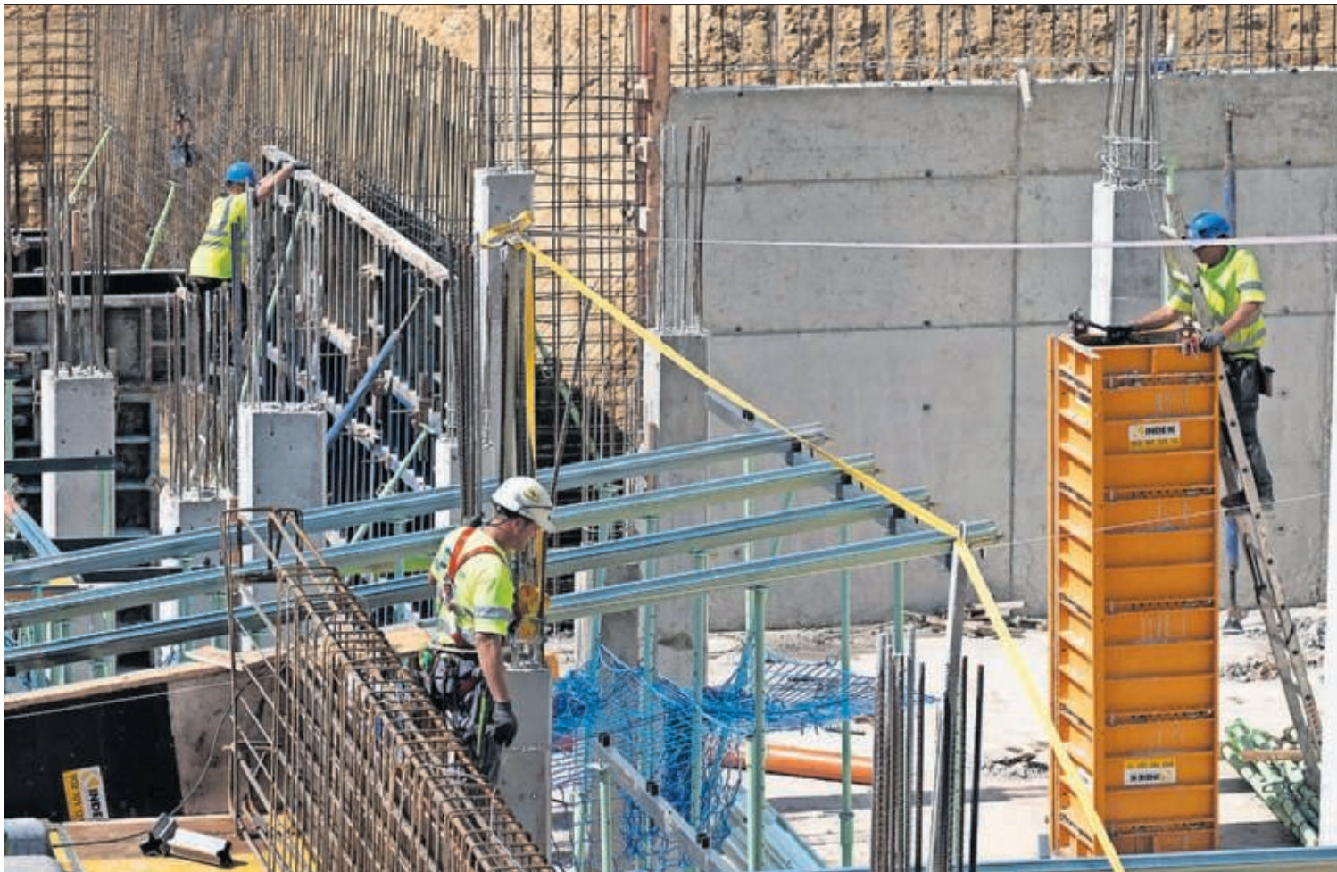
Tres empleados trabajan en la construcción de un bloque de viviendas, el lunes en Bormujos (Sevilla). / PACO PUENTES
